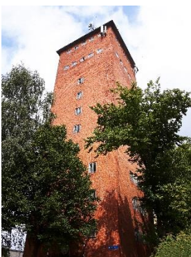
Wieża ciśnień na Zatorzu
