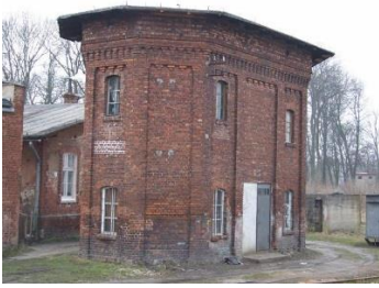
Wieża ciśnienia przy dworcu PKP w Morągu
