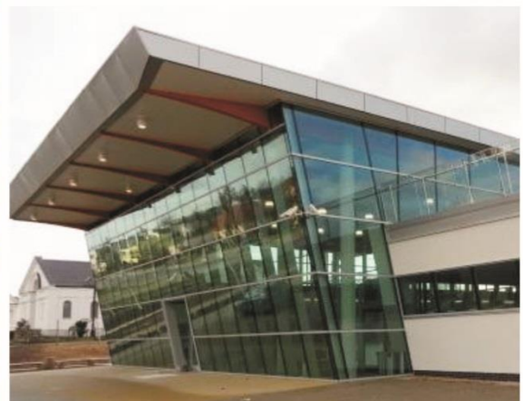
Pływalnia „Morąska Perła”
