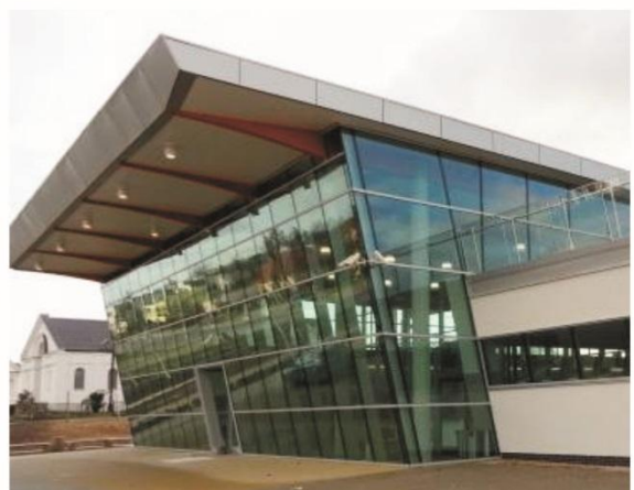
Pływalnia „Morąska Perła”
