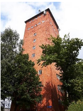
Wieża ciśniń na Zatorzu
