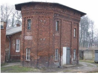
Wieża ciśnię przy dworcu PKP w Morągu
