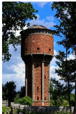
Wieża ciśniń w Morągu
