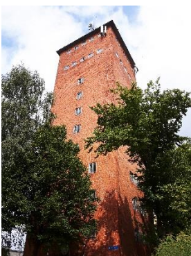
Wieża ciśniń na Zatorzu
