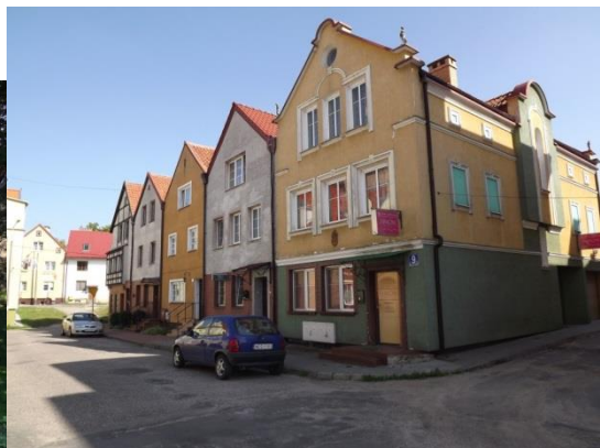
FRAGMENT ORYGINALNEJ ZABUDOWY STAREGO PRZED
