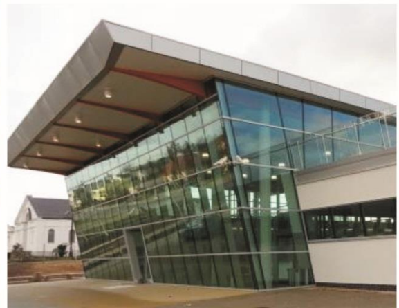
Pływalnia „Morąska Perła”
