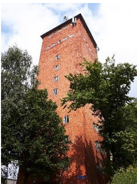
Wieża ciśnien na Zatorzu
